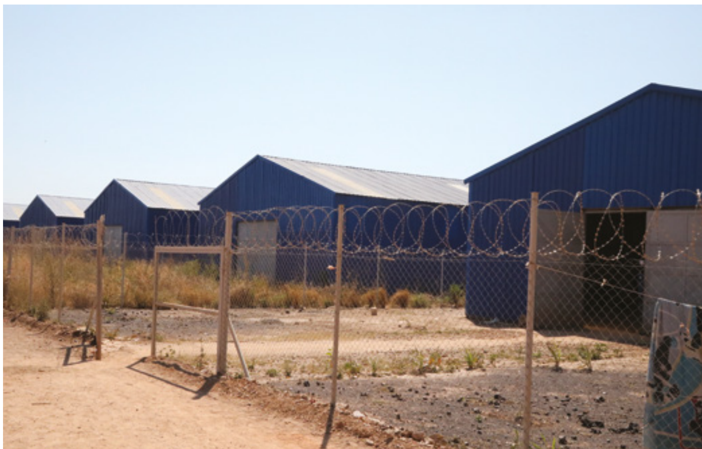
Quelques hangars du Centre de Négoce de MUSOMPO
